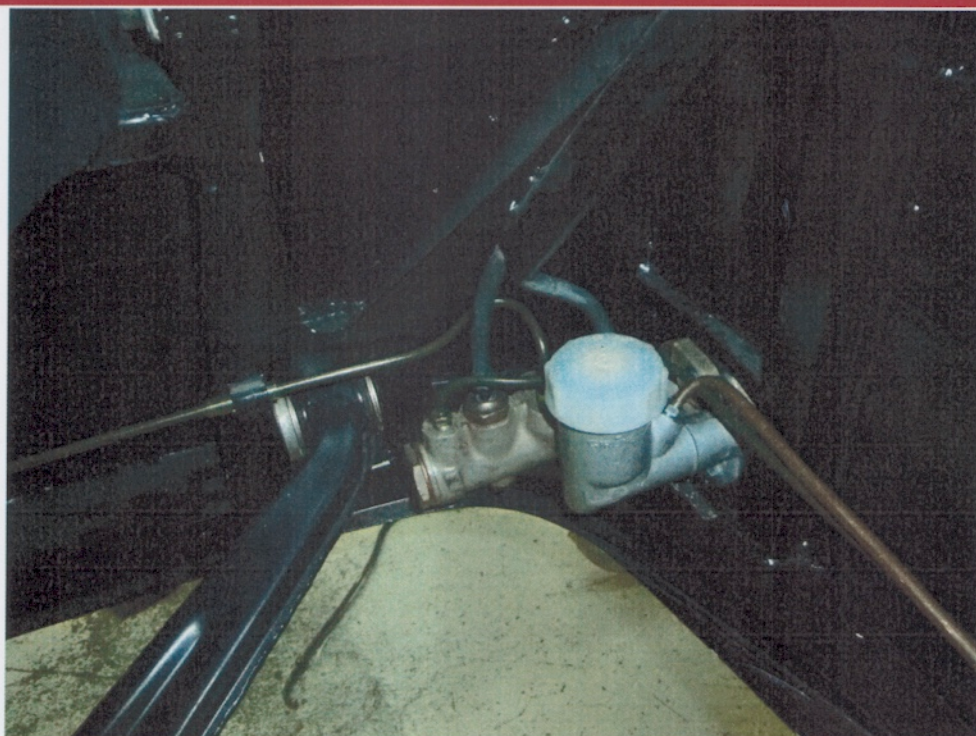
Verlegen und anpassen der Leitungen
